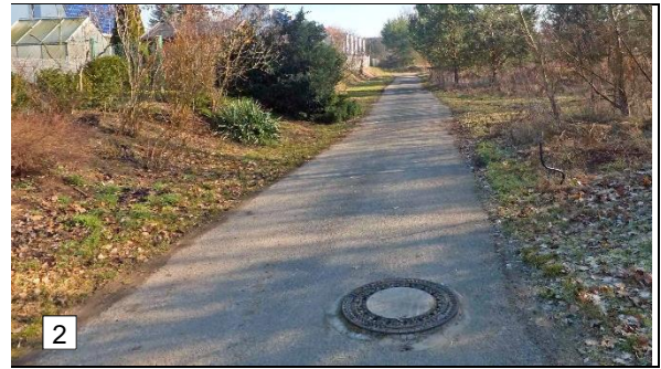
Bild 2: Die Hohenwestedter Straße ist bisher lediglich als Baustraße zwischen 2,50 und 3,0 m ausgebaut.
