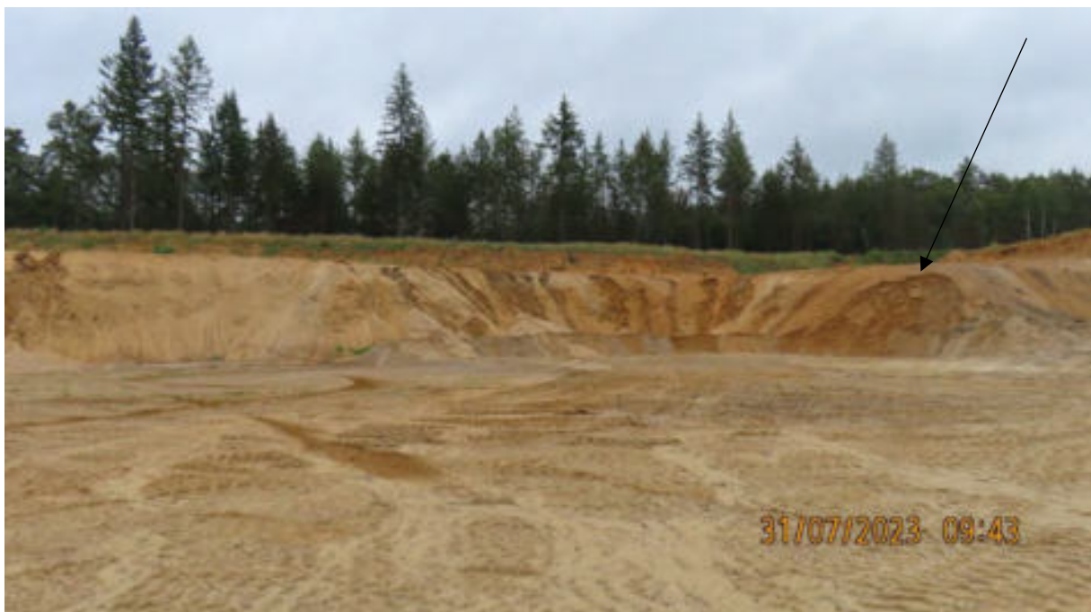
Abb. 5: Nordöstliche Trockenschnittböschung, Blick nach N
