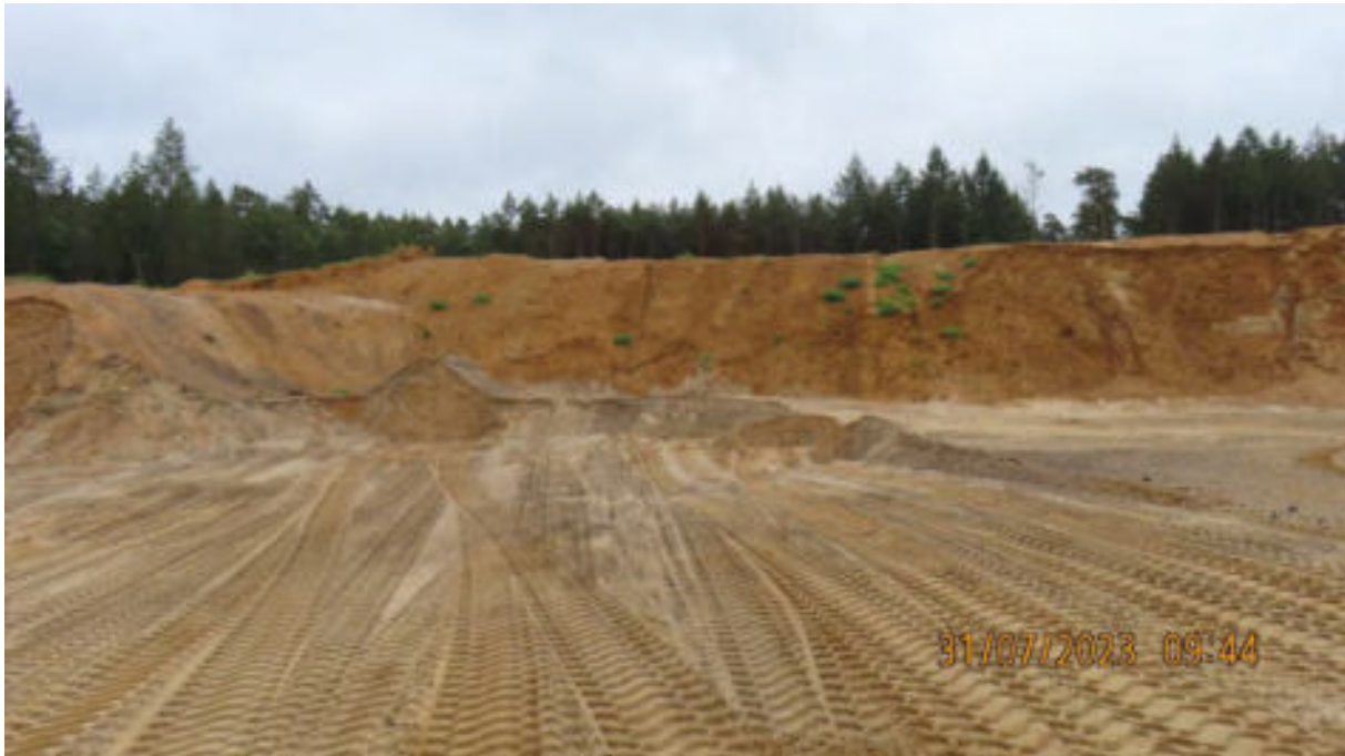
Abb. 5: Nordöstliche Trockenschnittböschung, Blick nach NO
