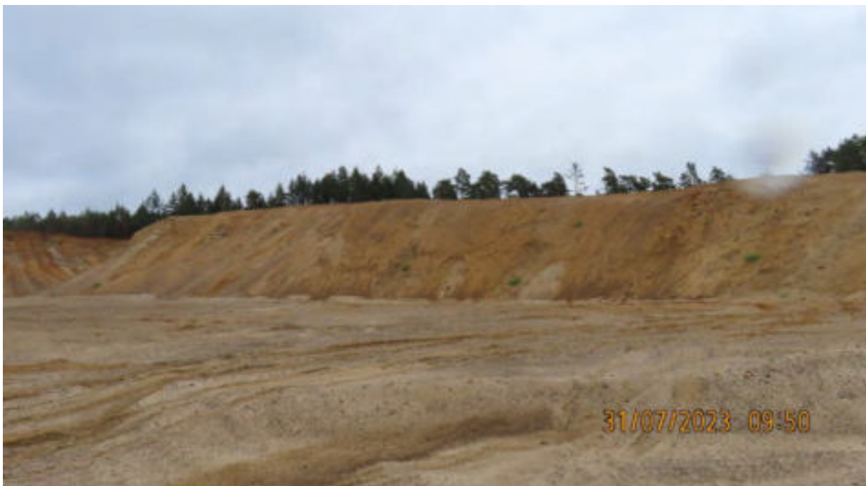
Abb. 8: Südostböschungen / Übergang Ostböschungen
