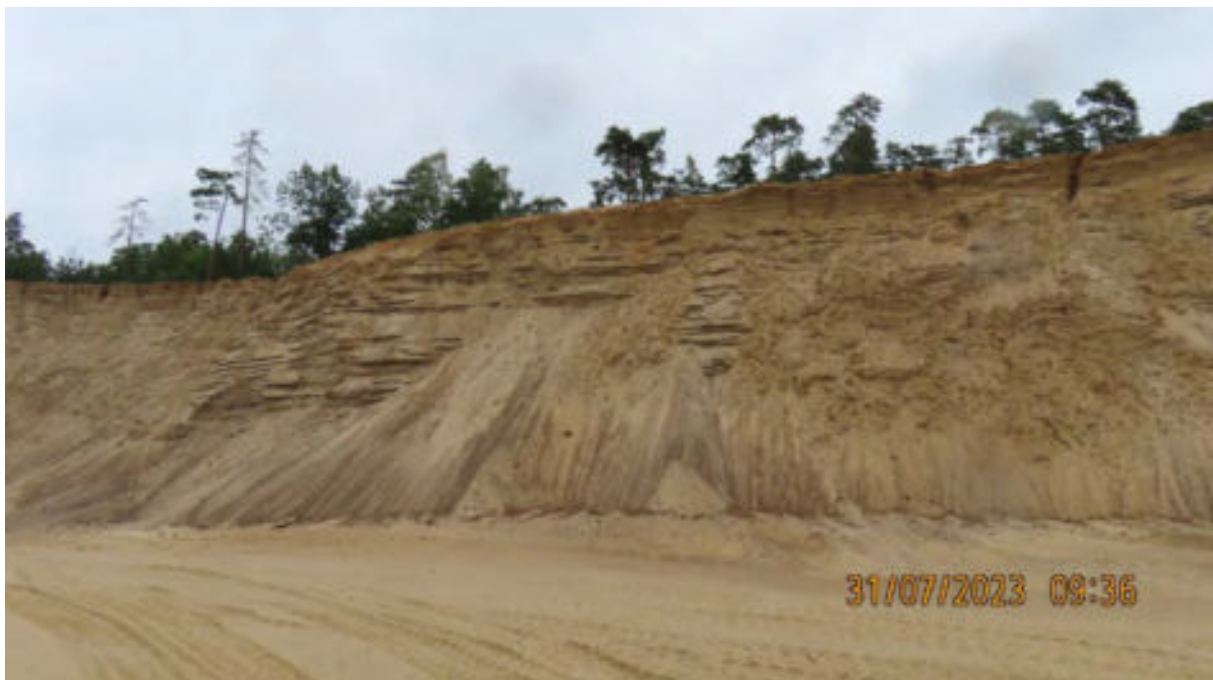
Abb. 3: Nordwestliche Trockenschnittböschung, Detail, Blick nach N
