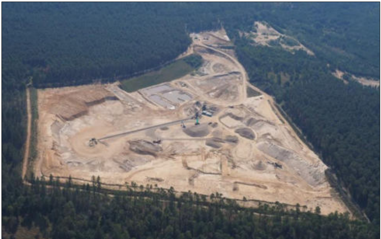
Abbildung 8: Tagebau Müncheberg Vorheide II mit Darstellung der stationären Aufbereitungsanlage, Frischwasser- und Absetzbecken; Blick vom westlichen Tagebaurand in östlich- bis südöstliche Richtung
