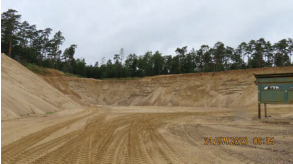
Abb. 2: Nordwestliche Trockenschnittböschung, Blick nach NW
