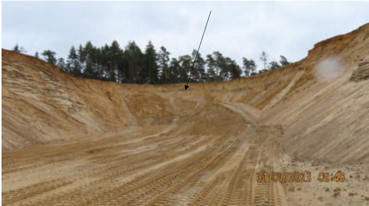
Abb. 7: Einschnitt im Bereich der Ostböschungen, Blick nach O
